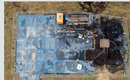
Emprise d'un atelier de forage
