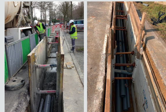
Pose fourreaux PVC sous voirie
