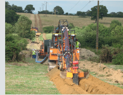
Pose fourreaux PEHD en plein champ à l'aide d'une trancheuse
